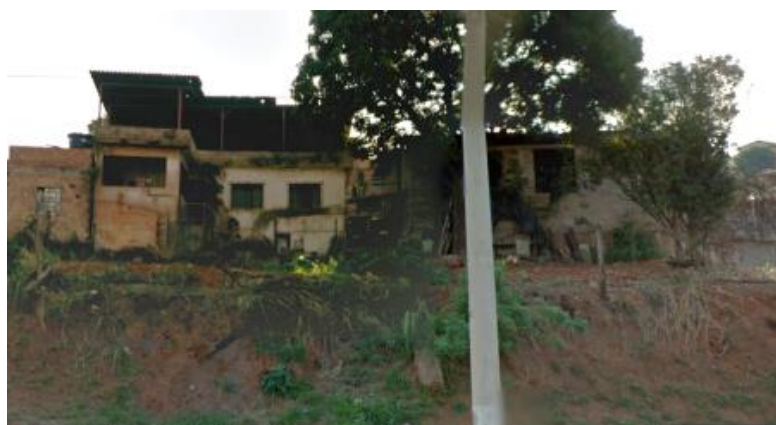
Figura 3.32 – Propriedade em que se localiza a nascente AR-179 (21/11/2016)
