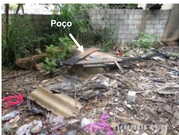
Figura 3.34 – Poço formado pela nascente AR-032 (21/11/2016)
