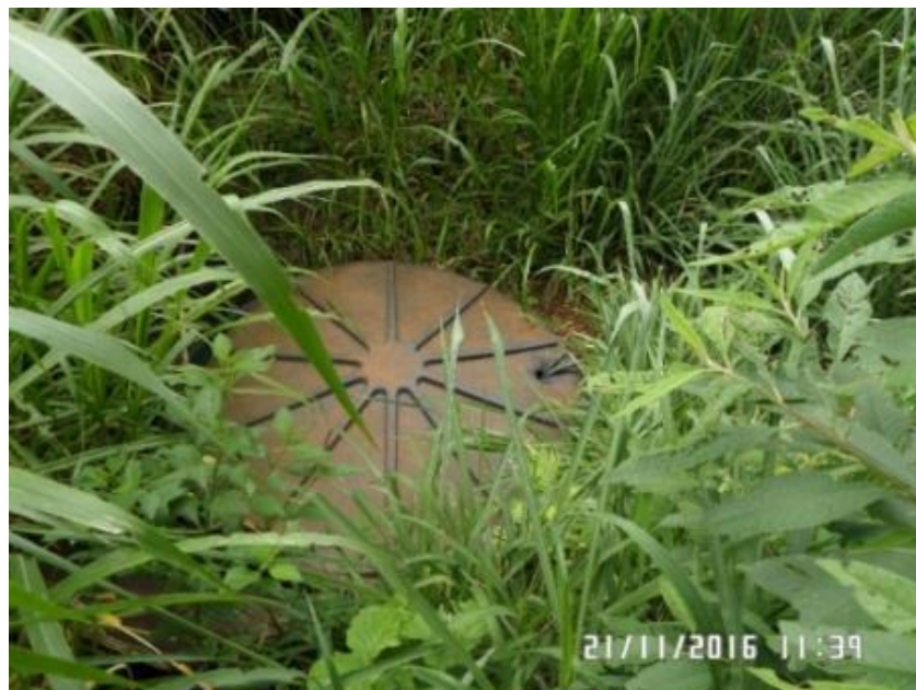
Figura 3.40 – Localização da nascente AR-183 (21/11/2016)
