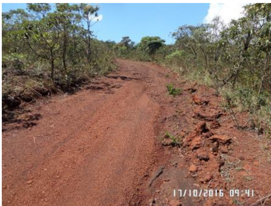
Figura 3.16 – Estrada vicinal – Mina do Tamanduá (17/10/2016)
