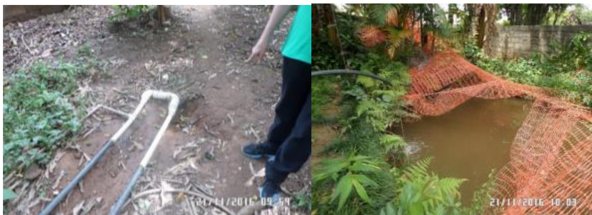
Figura 3.36 – Nascente AR-030 canalizada e direcionada para lago (21/11/2016)
