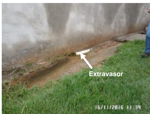
Figura 3.28 – Dreno localizado a jusante do Lago 1 (16/11/2016)
