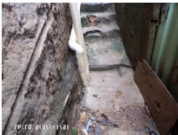
Figura 3.20 – Nascente AR-048 canalizada (16/11/2016)
