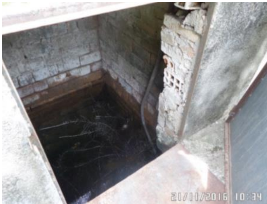
Figura 3.37 – Poço onde se localiza a nascente AR-183 (21/11/2016)
