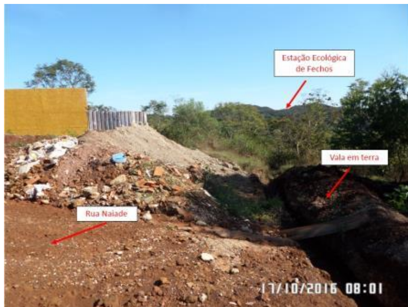
Figura 3.13 – Vala em terra implantada pela Prefeitura de Nova Lima (17/10/2016)
