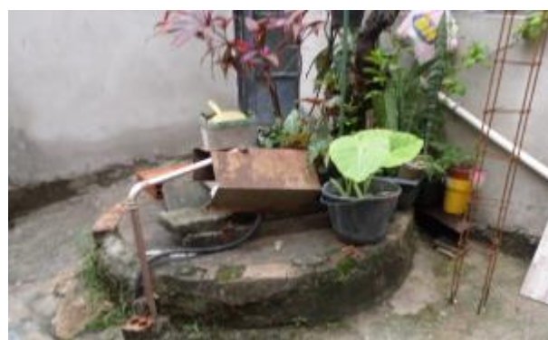
Figura 3.22 – Cisterna localizada no terreno (16/11/2016)
